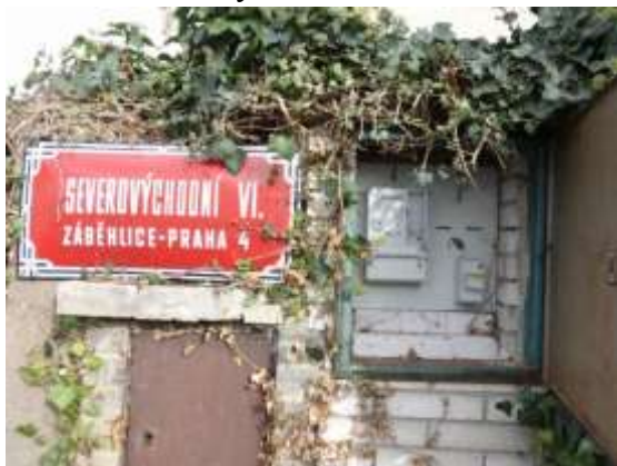
skříňka na elektroměr
