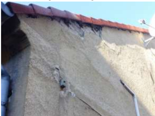
detail omítky na štítu
