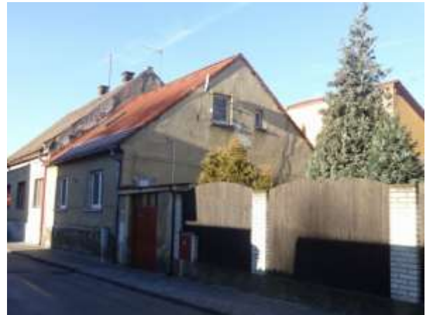
pohled od východu, s oplocením
