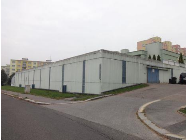
Pohled z jihovýchodní strany s vjezdovými vraty do 2.NP
