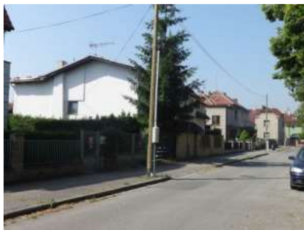
Štítová stěna z ulice Lažanského
