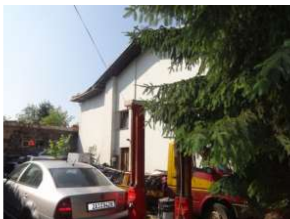
Štítová stěna a dvorek
