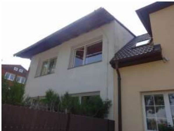
Uliční část domu + napojení na sousední dům
