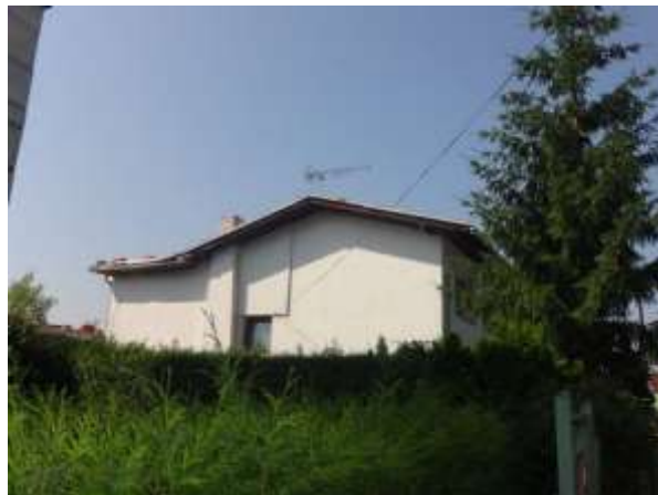
Štítová stěna detail
